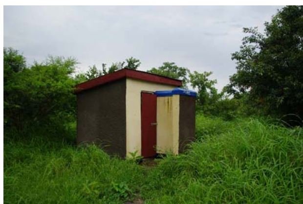
Figura 5 Volviendo la mirada atrás, las letrinas públicas no han contribuido mucho a la mejora del saneamiento excepto en las escuelas. Esta letrina había estado claramente en desuso durante algún tiempo, permanecía cerrada y nadie conocía el paradero de su llave.
